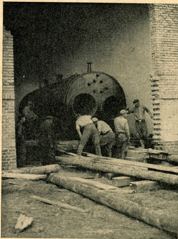
Dwikozy. Fragment budowy. Ustawianie kotła parowego.
