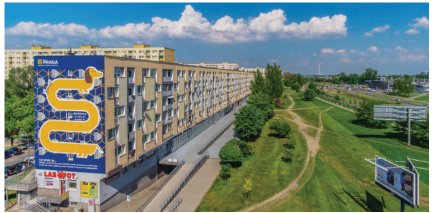
Brak regulacji stanu prawnego gruntów na rzecz spółdzielni prowadzi także do takich problemów, jak brak możliwości wybudowania chodników na przedseptach. (Fot: Facebook RSM Praga).
